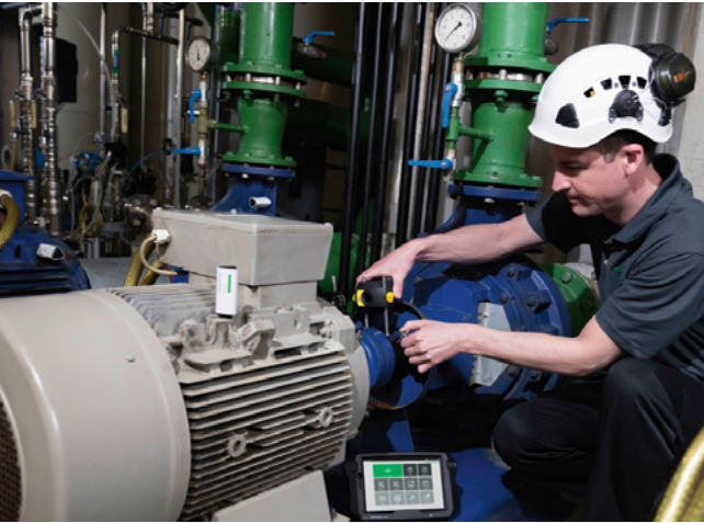
Ipari szerszámok – Igazítás Ipar: A LASER-EQUILIGN2 az egylézeres technológiának köszönhetően mindig biztosítja a gépek professzionális beállítását технология
