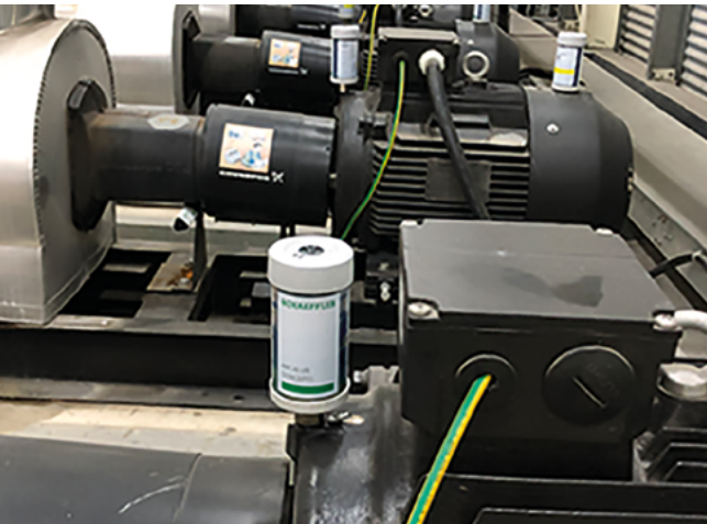
Kenési megoldás Papírgyár: Az OPTIME CM jól teljesít a motorfelügyeletben
